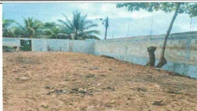
Foto 2: ya que contamos con una parte de la construccion.
