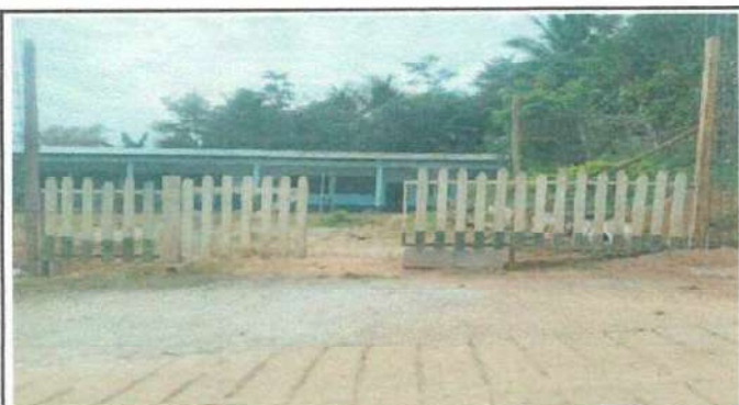
Foto 3: Se rehabilitara un porton de puro metal con medidas de 5.30 metros de largo.
